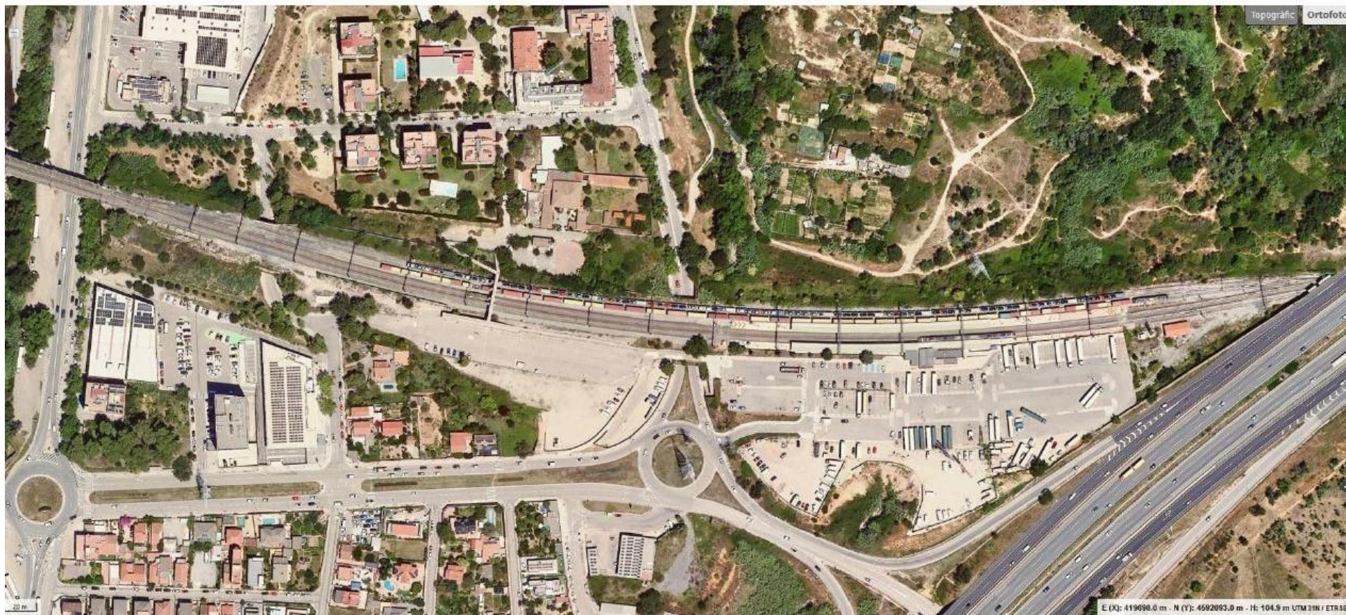
Estat actual de l'estació de Rubí
