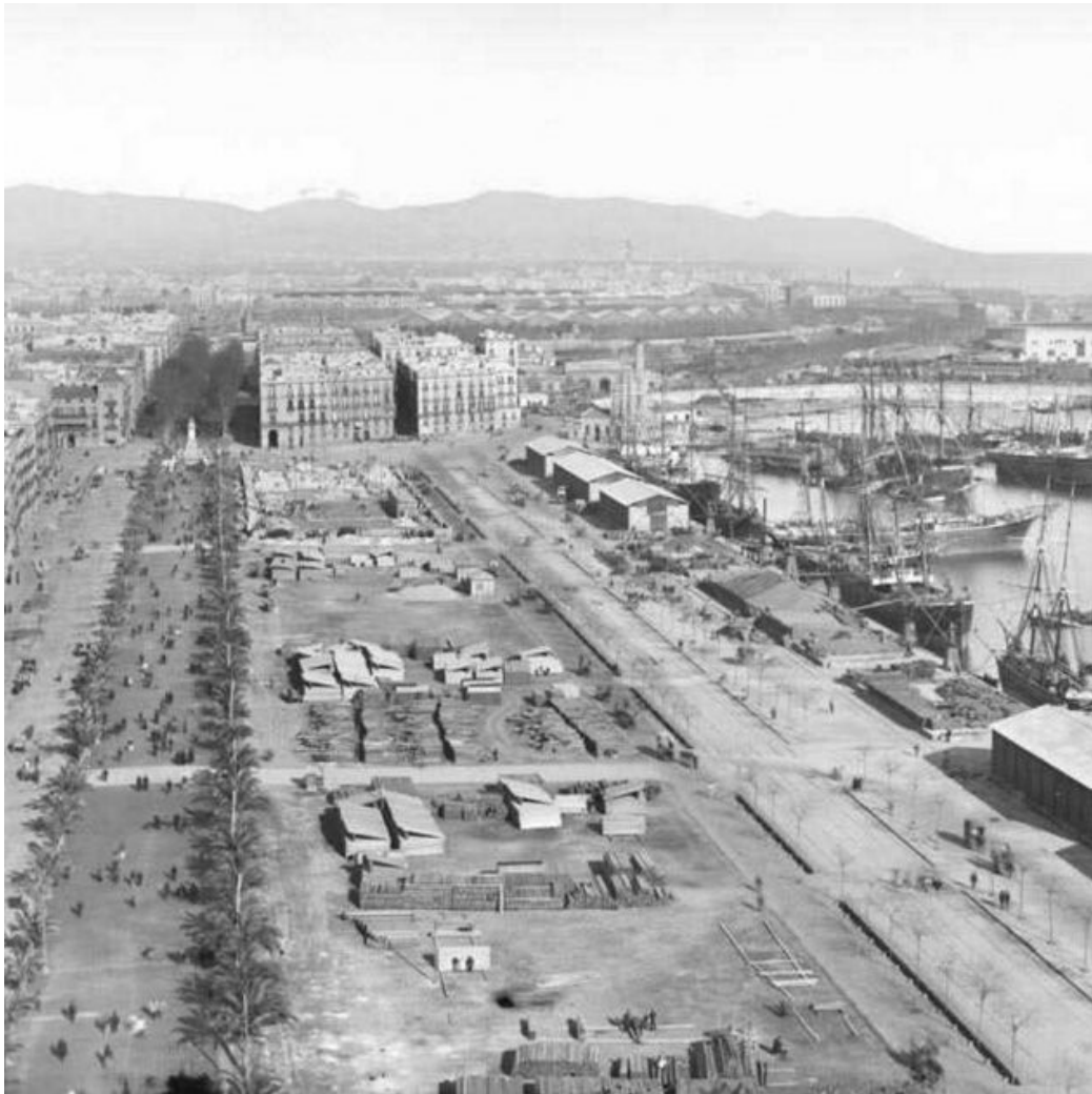
El Moll de la Fusta no és pròpiament una façana de ciutat a mar, és un descampat, que podria allotjar una avinguda urbana i una façana edificada, com sí hi és al Palau de Mar
